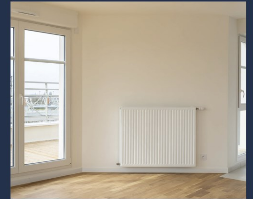
La résidence est raccordée au réseau de chaleur urbain
